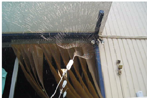
図3 チューブノズルの散水状態
